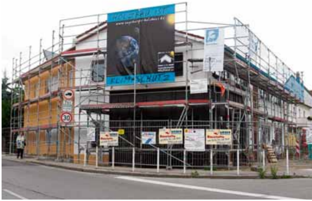
Auf dem 700 Quadratmeter großen Anwesen in der Dr.-Gerlich-Straße in Neusäß entsteht derzeit das Wohn- und Geschäftshaus von Familie Maderholz. Foto: Marcus Barnstorf
